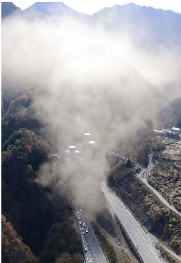
崩落事故があった中央自動車道上り線の笹子トンネル入り口から立ち上る煙 = 2日午前9時45分、山梨県甲州市で共同通信社ヘリから
